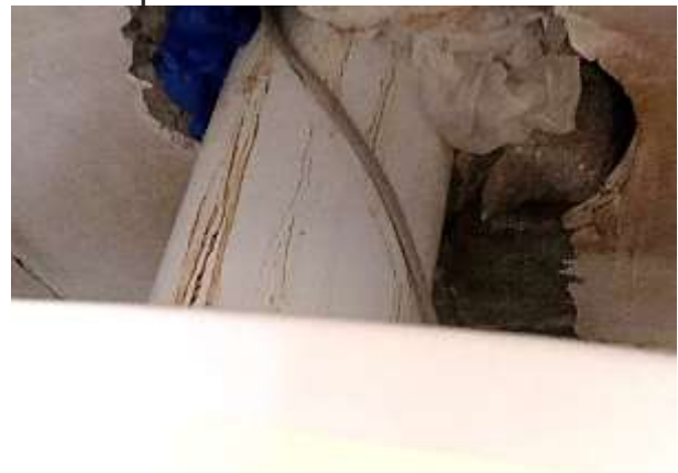
Coulées rougeâtres (corrosion) visibles sur conduit concentrique Ø80-125 mm – lot 2 – L5 - 0
