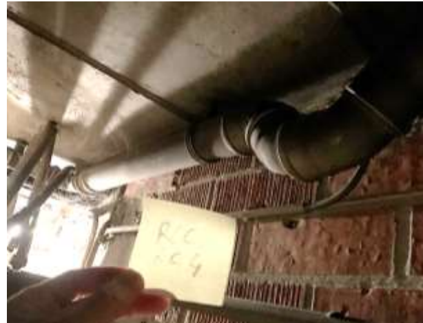
Amenée d'air directe dans le local dédié - lots 2- RCG-0 _ 2-RCC-0
