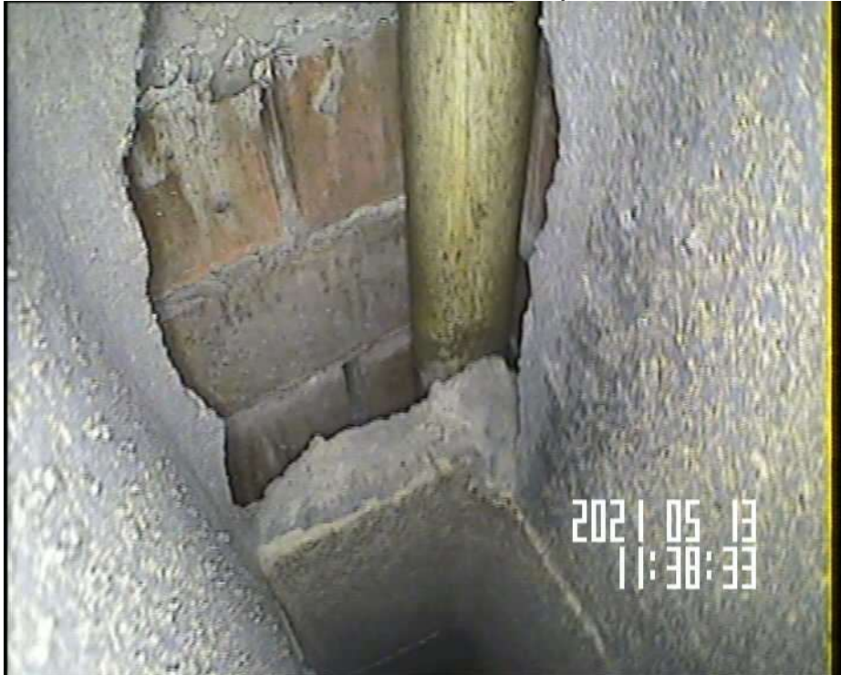
Communication entre le ramon F4 et la trémie technique du shunt GB B36 G
