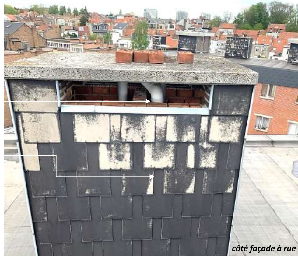
Trémie de ventilation D2 arrière avec conduits d'évacuation des gaz brûlés individuels des lots 1 - J6 - 0 (atmosphérique) & 1 - I6 - 0 (condensation)
