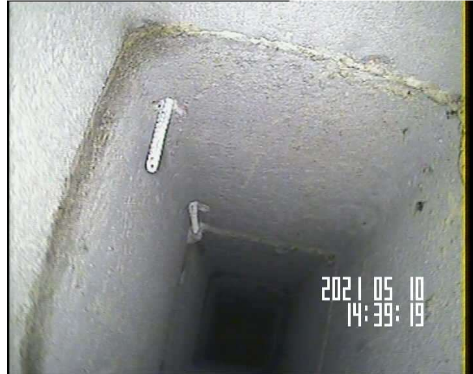
Présence de 2 vis à 17 m sur le shunt GB D1 D
