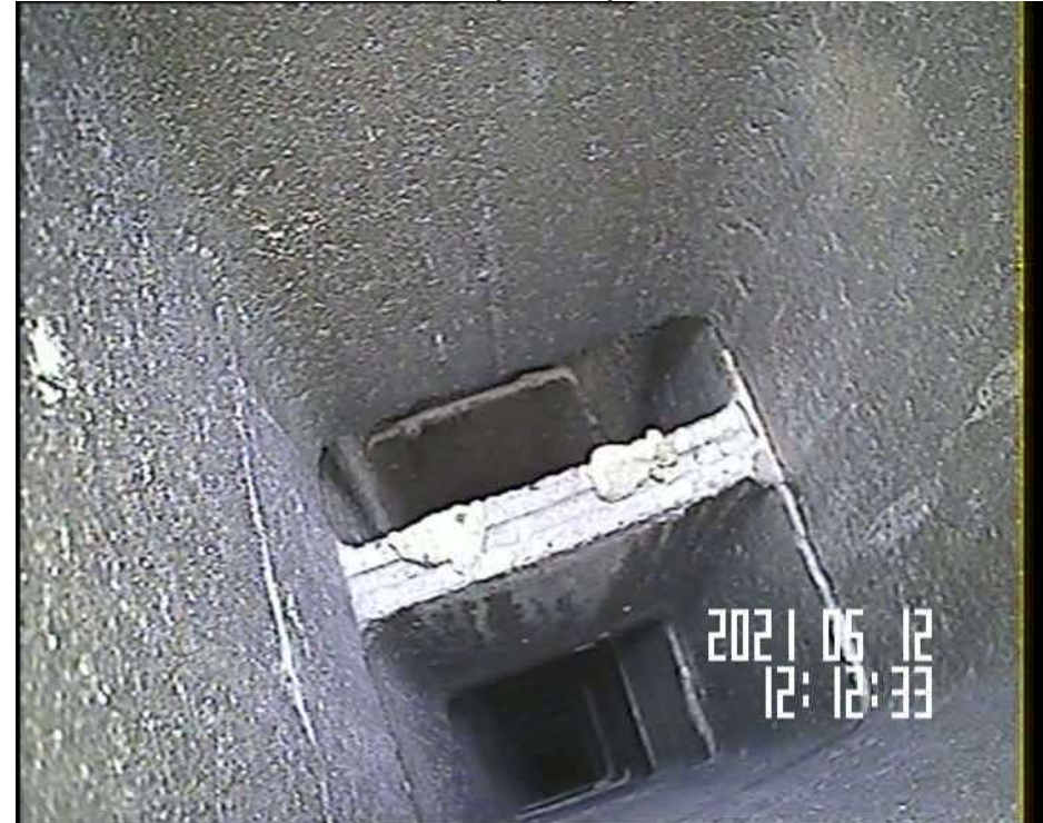
Pose inversée d'un élément shunt en partie supérieure du shunt GB B42 D
