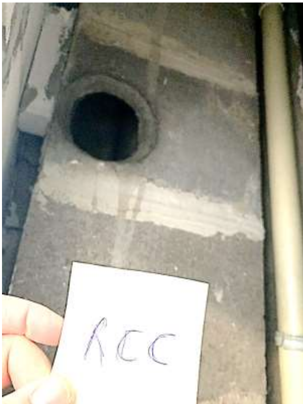
Ancien raccordement sur shunt collectif non obturé – lot 2 – RCC – 0 – niveau rez
