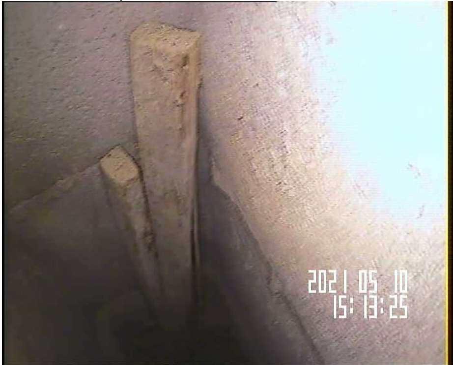
Planches de bois en pied de shunt GB D2 G
