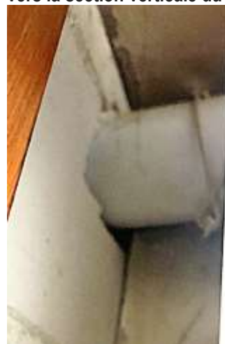
Conduit concentrique Ø60-100 mm avec contre-pente vers la section verticale du conduit – lot 2 – L-5 - 00
