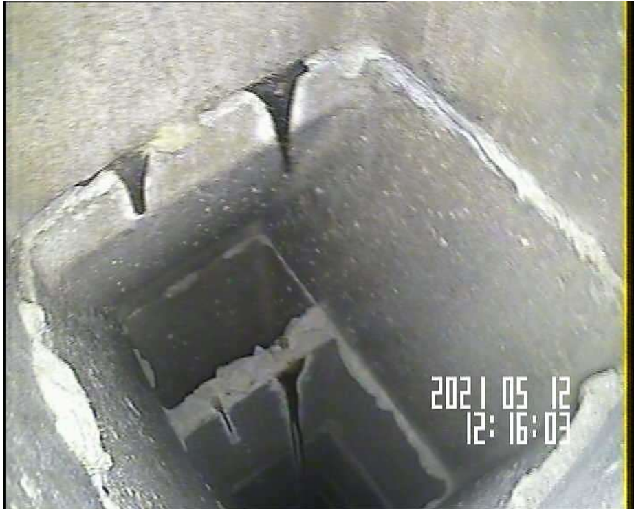
Traces noirâtres à hauteur du ramon F-2 sur le shunt GB B42 D
