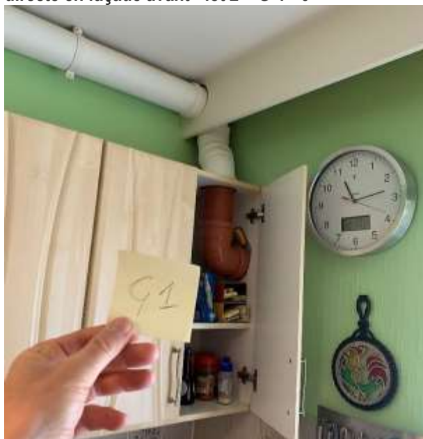
Ventilation basse du local de chauffe via prise d'air directe en façade avant - lot 2 – G-1 - 0
