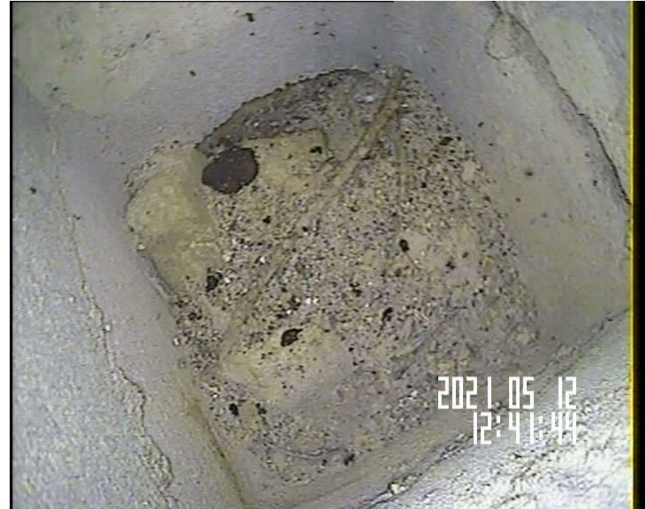
Pied de conduit en shunt GB V6 D
