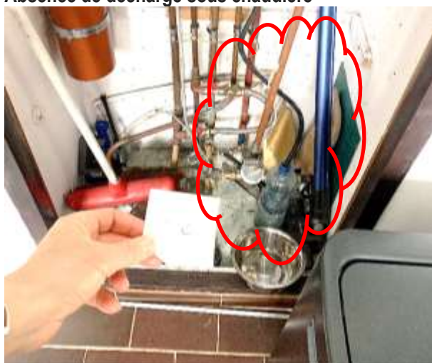
Absence de décharge sous chaudière
