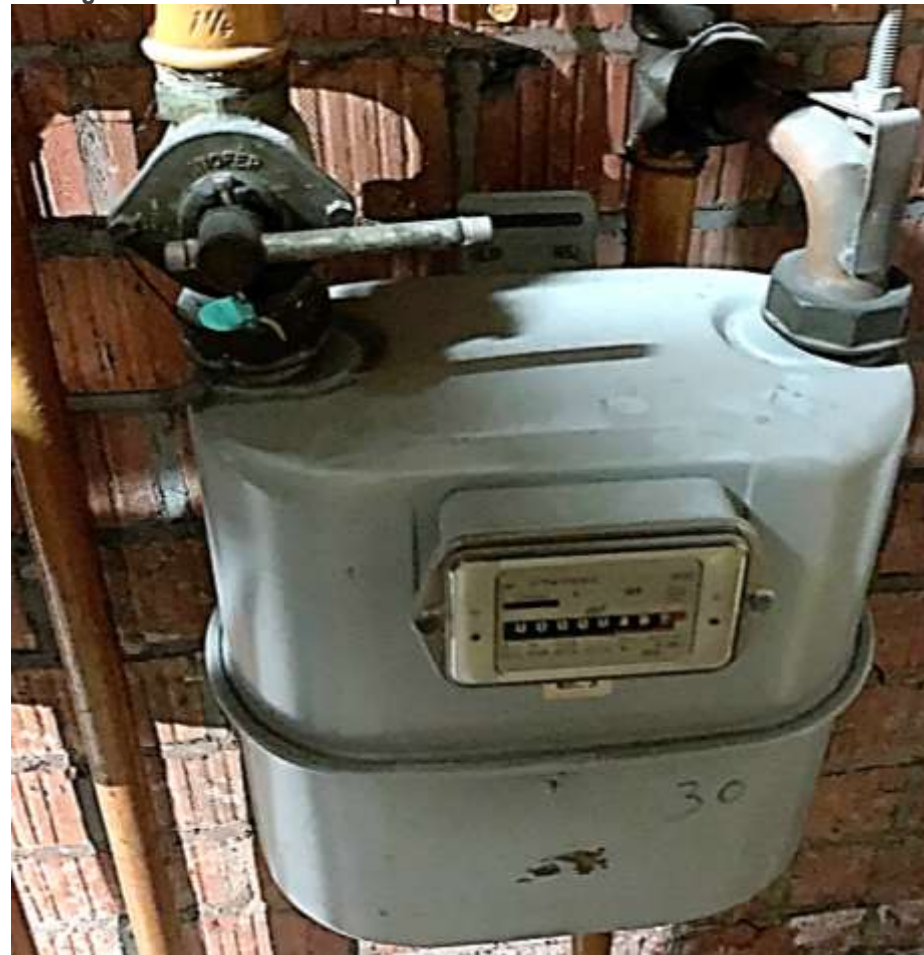
Local gaz aile Droit / Vérité – compteur n° 30 scellé & sans consommation
