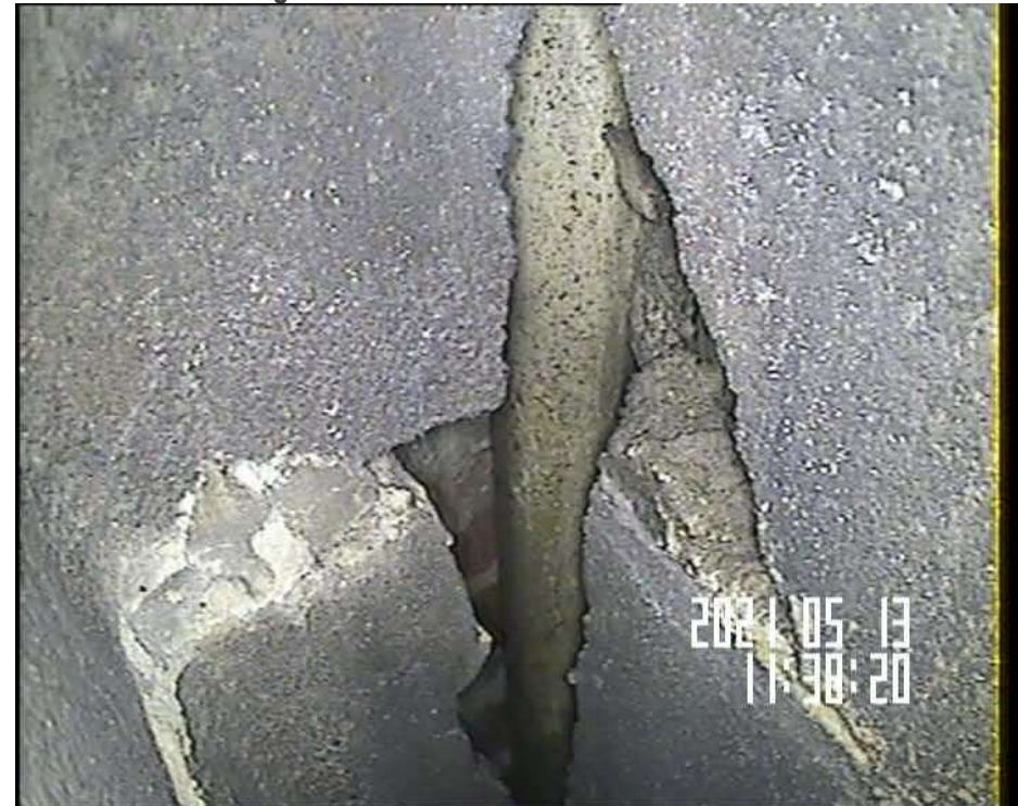
Ramon F4 endommagé sur le shunt GB B36 G
