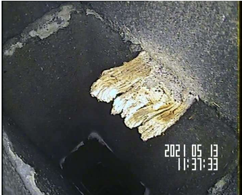
Planche de bois débordant dans le ramon F4 sur le shunt GB B36 G
