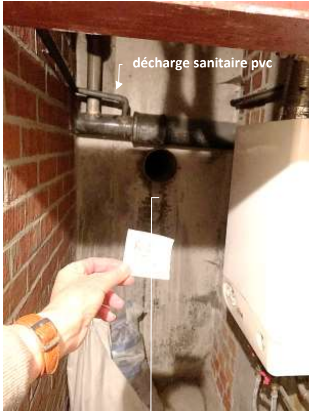
Amenée d'air directe dans le local dédié en sous-sol - lots 2-RCG-0 _ 2-RCC-0
