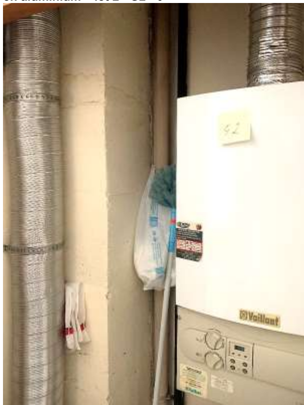
Ventilations haute & basse de l'espace via un flexible en aluminium – lot 2 - G2 - 0
