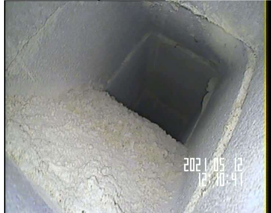
Dévoisement sur le shunt de gaz brûlés B42 G
