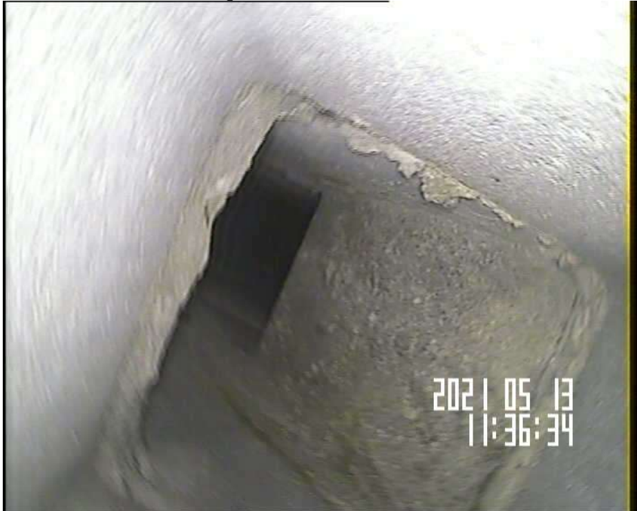
Dévoisement sur le shunt de gaz brûlés B36 G
