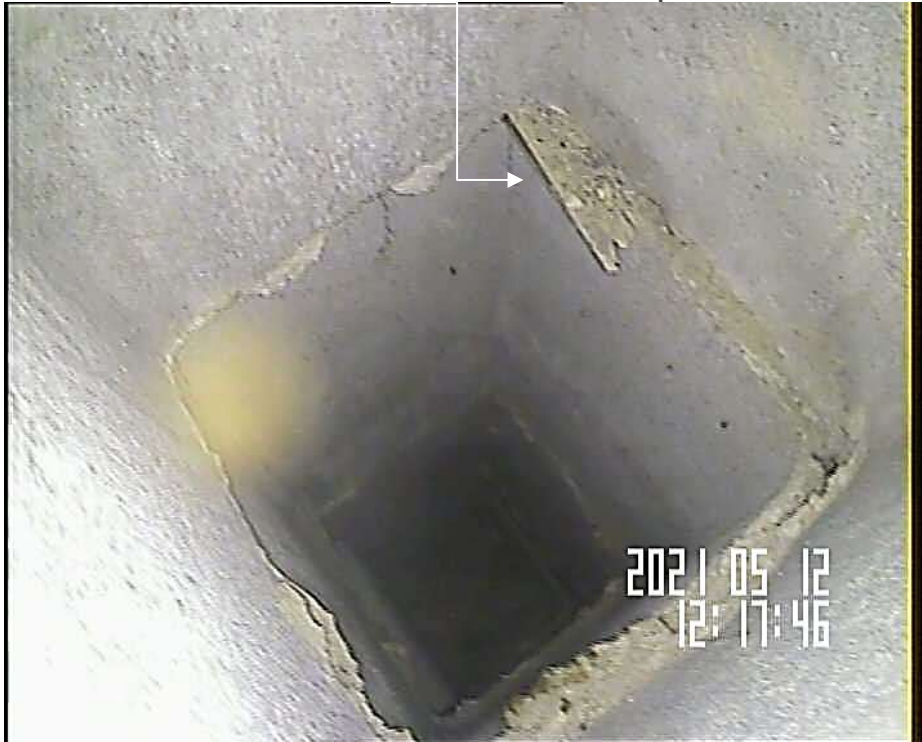
Morceau de bois débordant dans la section collective en pied de conduit GB 42 D
