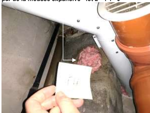
Ancien raccordement B 11 sur shunt collectif obturé par de la mousse expansive - lot 2 – F4 - 0
