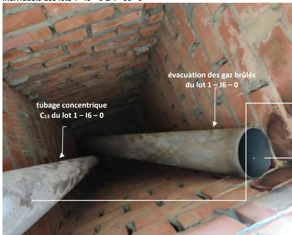
Trémie de ventilation D2 arrière avec conduits d'évacuation des gaz brûlés individuels des lots 1 - I6 - 0 & 1 - J6 - 0
