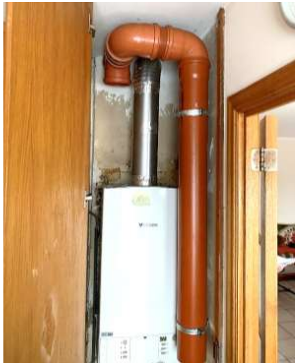
Ventilations haute & basse via une même gaine – lot 1 – A5 - 0
