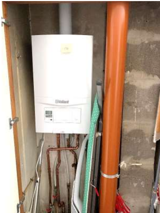
Espace d'installation & raccordement concentrique en lot 2 - F4 - 0
