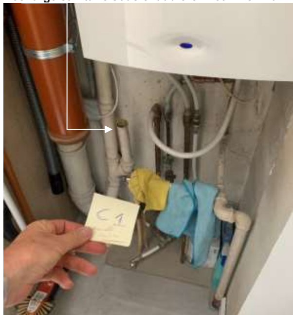
Décharge sanitaire sous chaudière – lot 1 - C1 - 0
