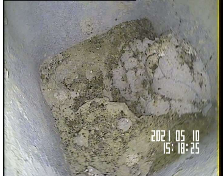
Pied de conduit de dim. 200 x 200 avec regard obturé sur shunt GB D2 D
