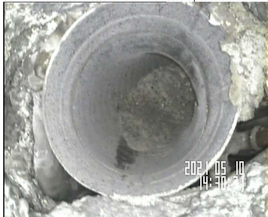
Connexion de la buse de raccordement 1-MAG-0 sous le pied du shunt GB D1 G
