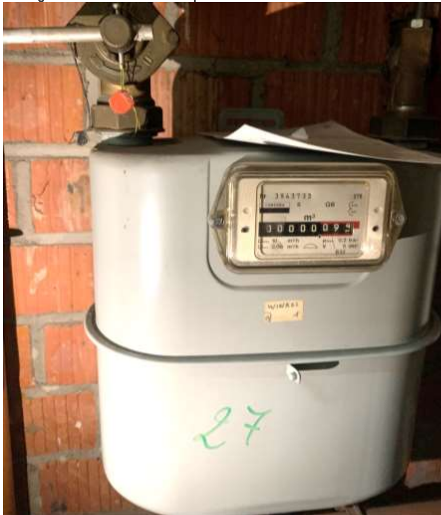
Local gaz aile Droit / Vérité – compteur n° 27 scellé & sans consommation
