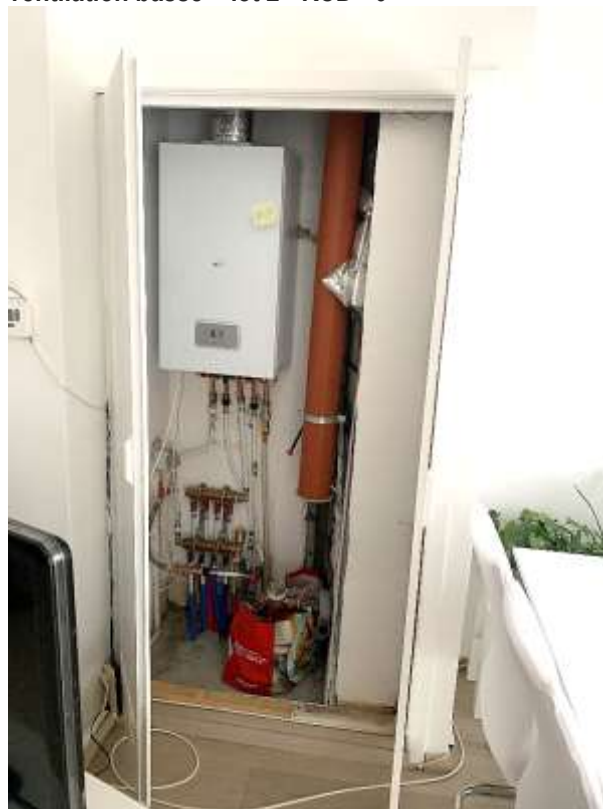
Espace de chauffe avec décharge sanitaire & ventilation basse – lot 2 - RCD - 0
