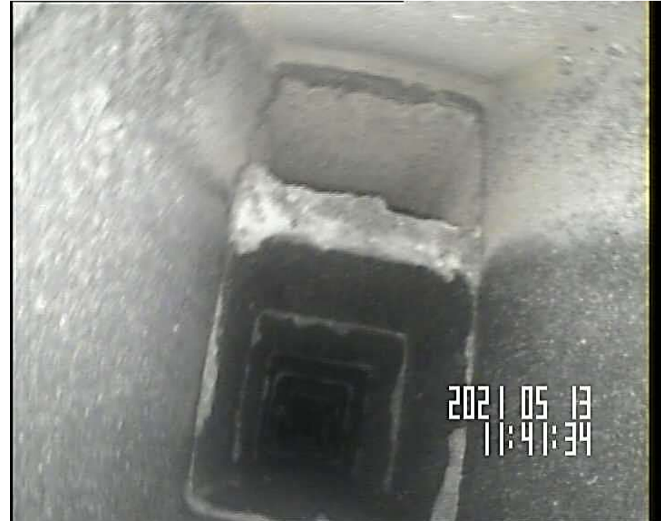
Section de shunt 200 x 200 avec ramons 200 x 125 mm
