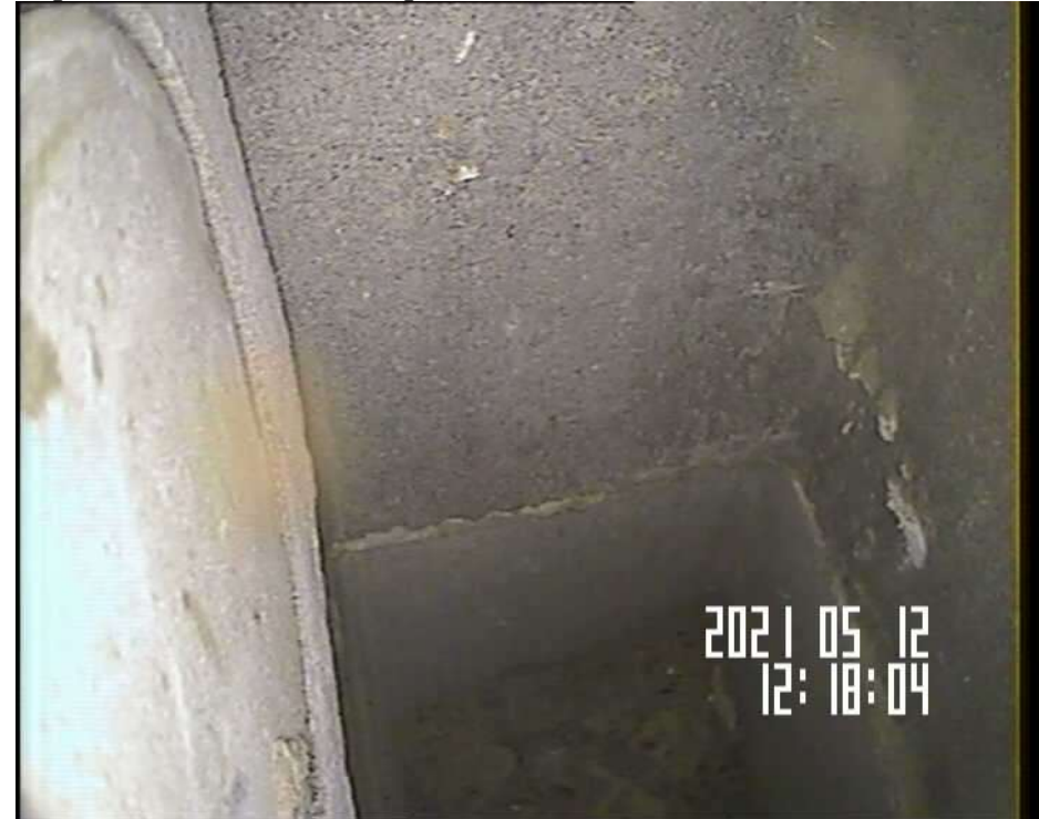
Regard en béton sur shunt de gaz brûlés B42 D
