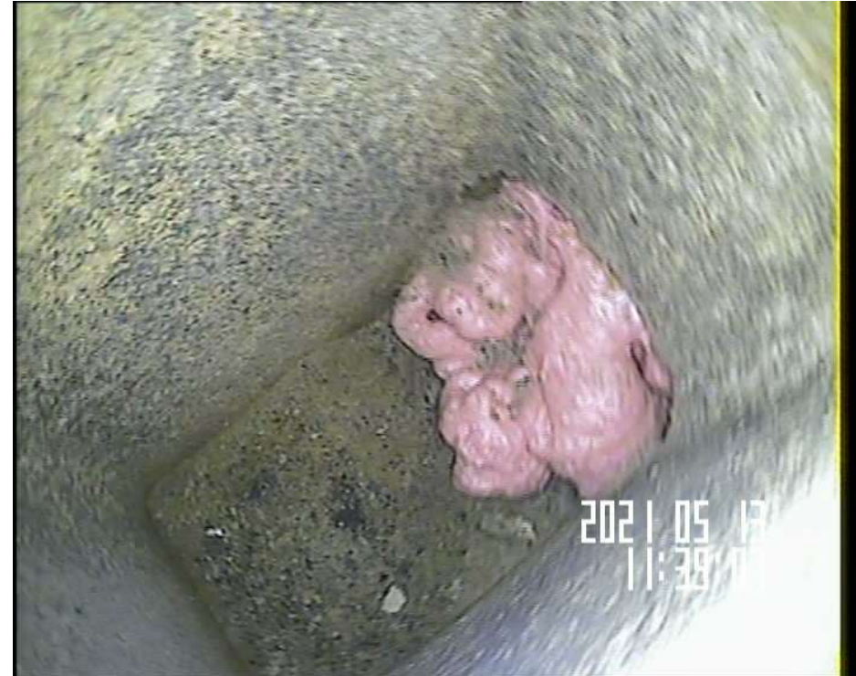
Bas ramon F4 avec raccordement obturé – shunt GB B36 G
