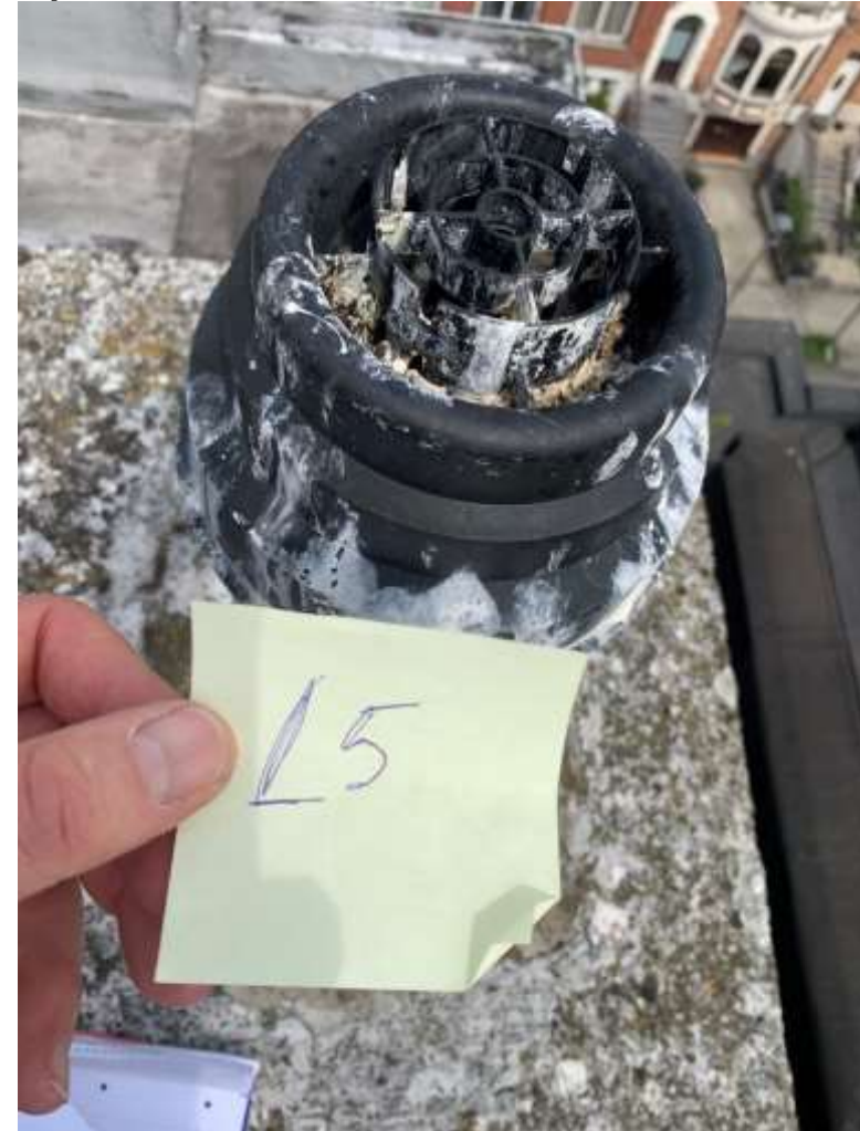
Déjections d'oiseaux encrassant l'amenée d'air du terminal – lot 2 – L5 - 0
