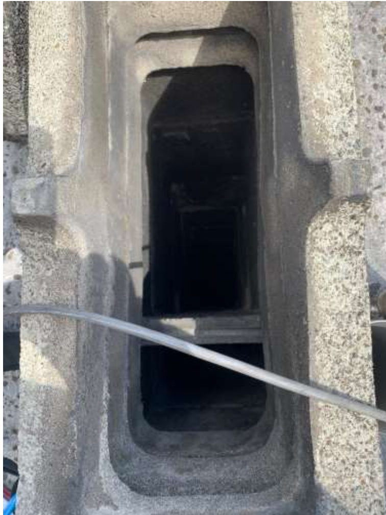
Section de shunt 200 x 350 avec ramons 200 x 125 mm
