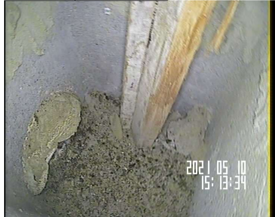
Planches de bois en pied de shunt GB D2 G – section de 200 x 200 mm
