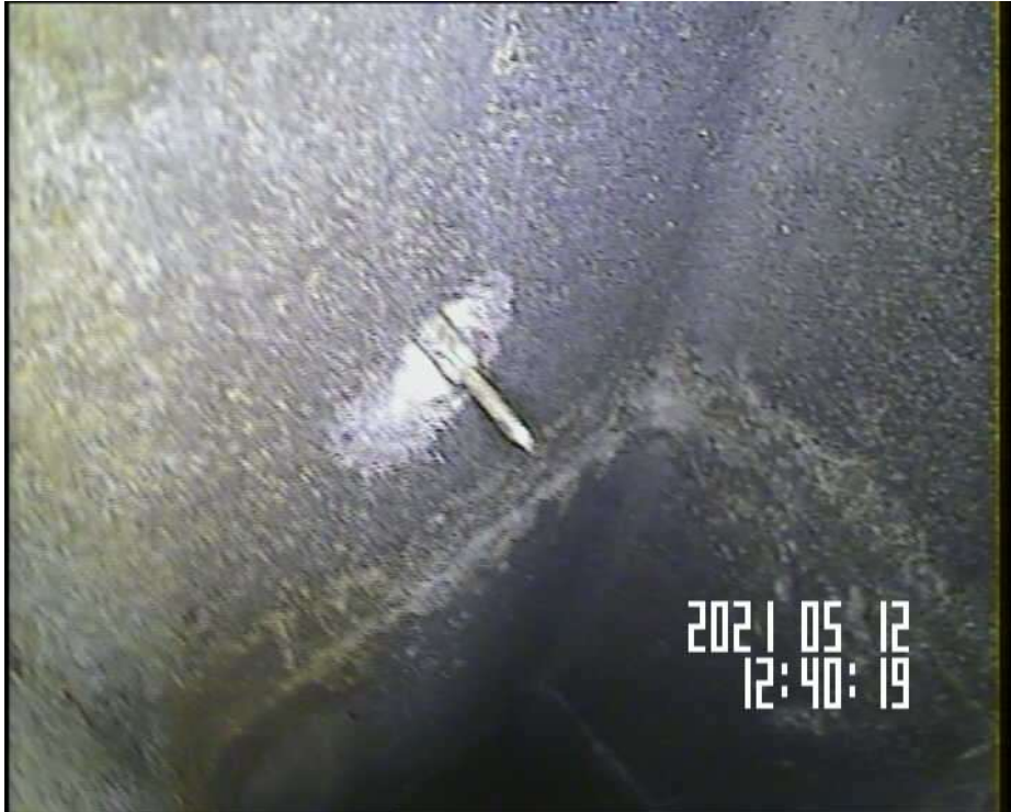
Présence d'une vis à 4m50 sur shunt GB V6 D
