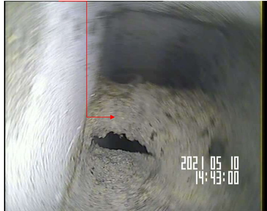
Section collective bouchée à la sortie du dévoisement – shunt GB D1 D
