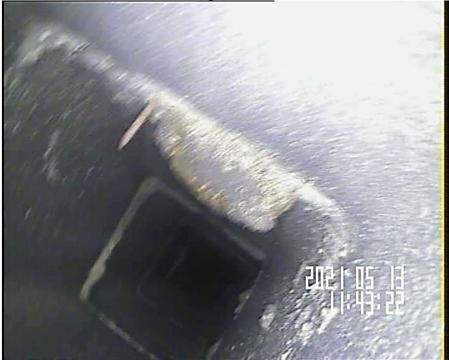
Présence d'un clou à 11m40 – shunt gaz brûlés B36 D
