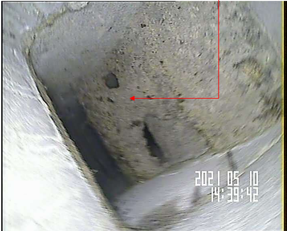
Dévoisement de 45° sur le shunt GB D1 D
