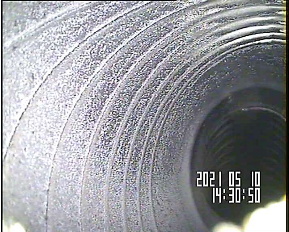
Formation d'un coude à 90° sur le conduit de raccordement du lot 1-MAG-0
