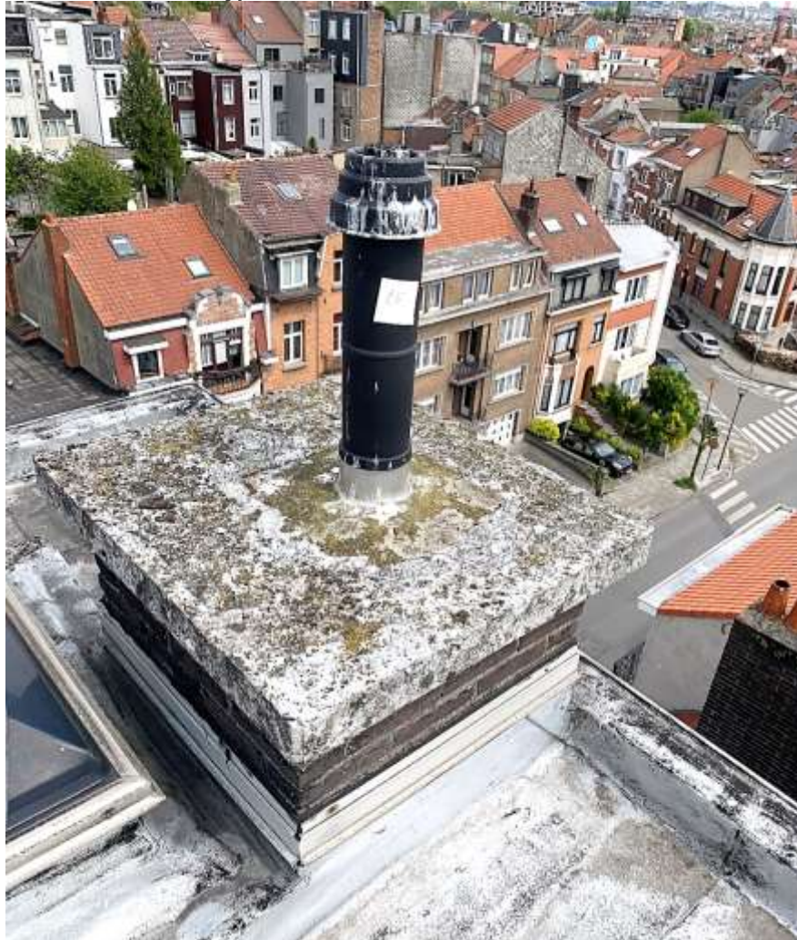
Terminal vertical de type C 33 du lot 2 - L5 - 0
