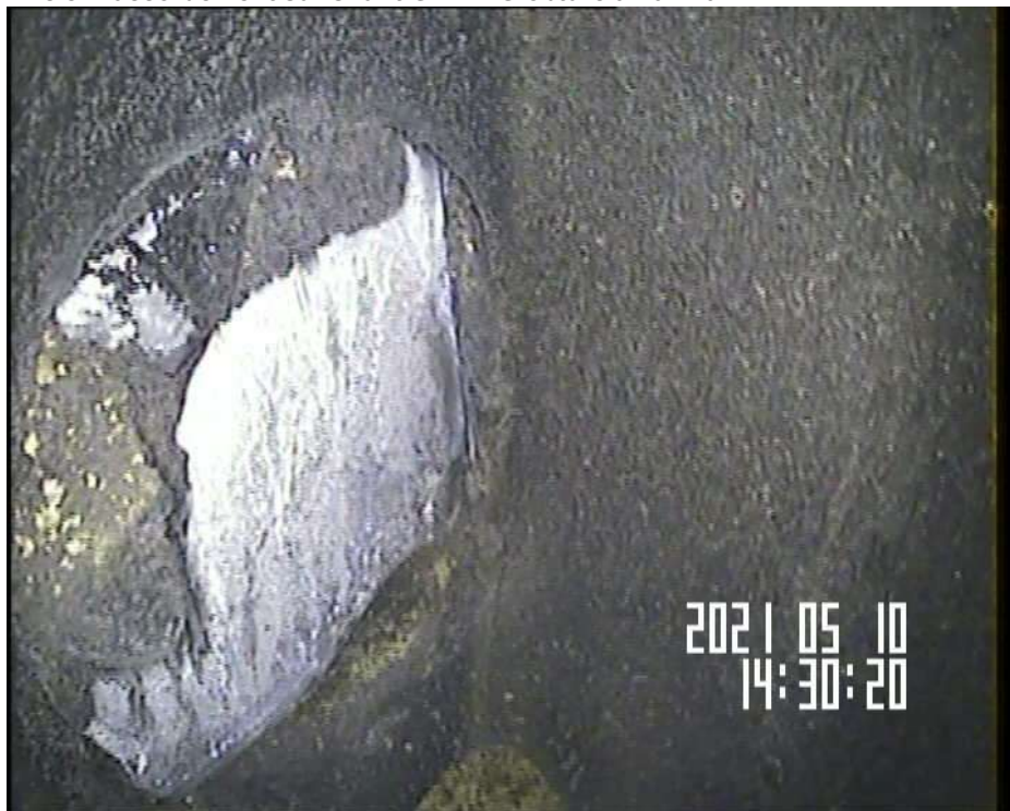
Ancien raccordement sur shunt GB D1 G obturé à 20m70
