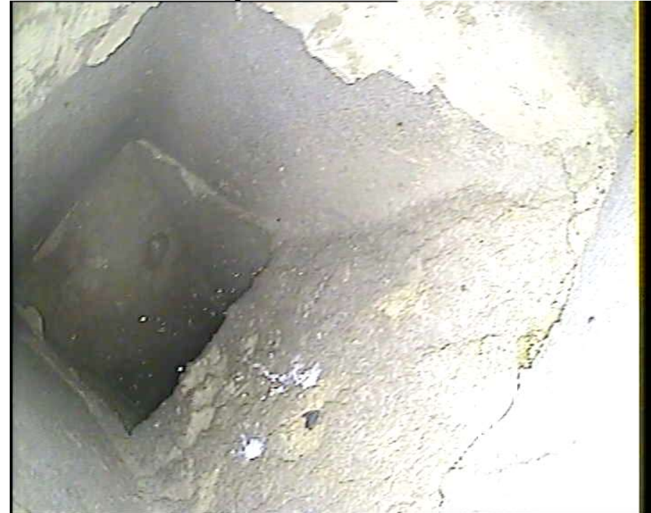
Dévoisement sur le shunt de gaz brûlés B42 D & section 200 x 200 au-delà
