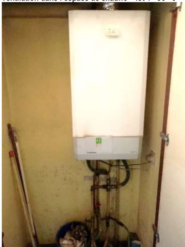
Absence de décharge sanitaire & de gaine de ventilation dans l'espace de chauffe – lot 1 - J6 - 0
